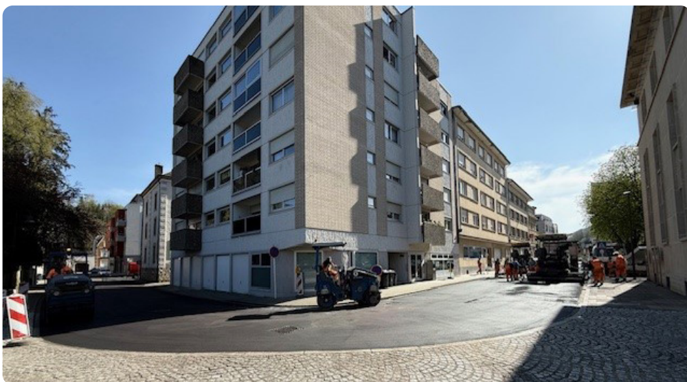
↑ Réfection rue des près
